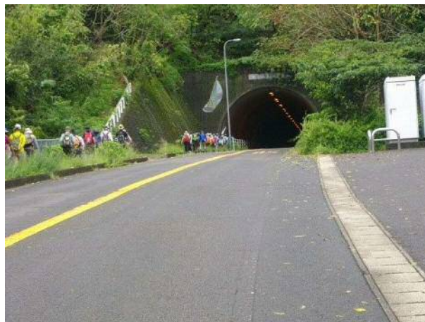
06 七宝山トンネル入口
