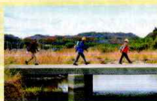
土器川 沈下橋
